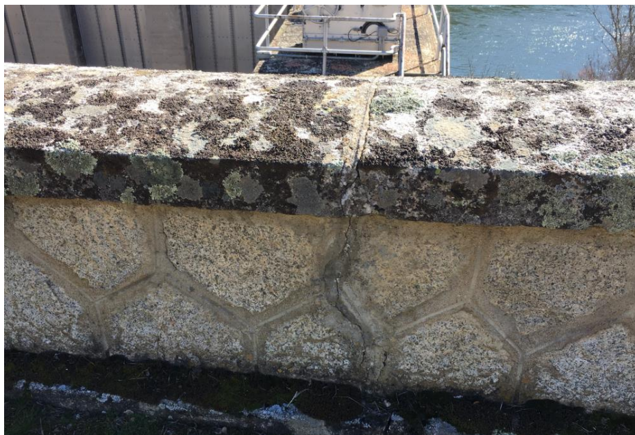
GRIETA Nº 2 EN EL PRETIL DEL MURO DESDE LA PLATAFORMA
