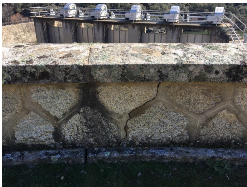
GRIETA Nº 3 EN EL PRETIL DEL MURO DESDE LA PLATAFORMA
