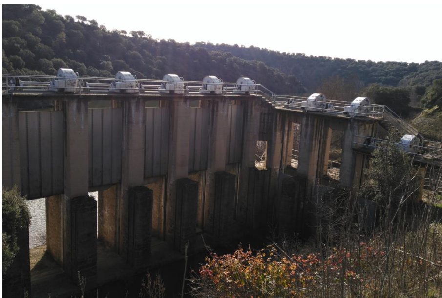
COMPUERTAS DEL AZUD DEL TENEBROSO
